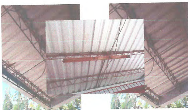
Foto 3: REPARACIÓN DEL SISTEMA ELECTRICO
