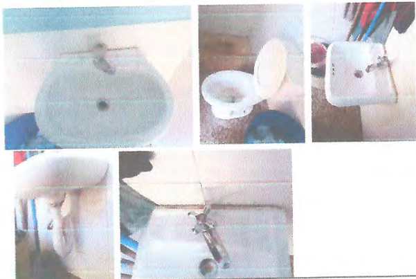
Foto 1: REMOZAMIENTO DE SERVICIOS SANITARIOS
